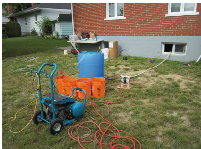
Installation du matériel d'injection.
